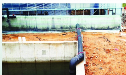
해수열 히트펌프 70RT×2대 지 역 : 신안 어 종 : 새우
