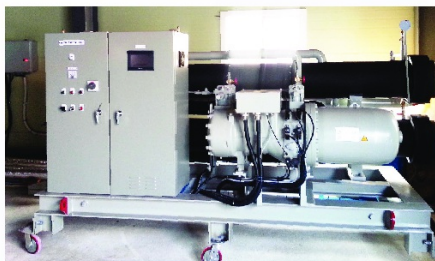
해수열 히트펌프 50RT×1대 지 역 : 고성 어 종 : 전복 / 굴
