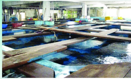
해수열 히트펌프 70RT×1대 지 역 : 통영 어 종 : 문어 / 방어 / 돔
