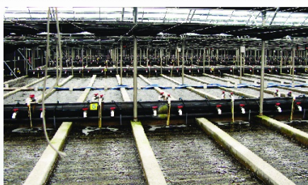
해수열 히트펌프 70RT×6대 지 역 : 완도 어 종 : 전복
